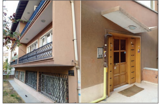
Şekil 5. Maltepe'deki Muhabank ikramiye apartmanının yıkılmadan önceki hâli.
