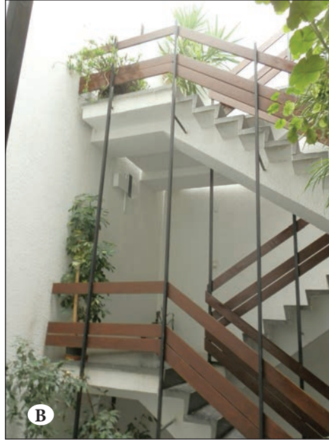
Şekil 26A. Çankaya İş Bankası İkrâmiye apartmanlarının galeri boşluğu ve çatı-penceresi. Fotoğraf: Umut Şumnu.
