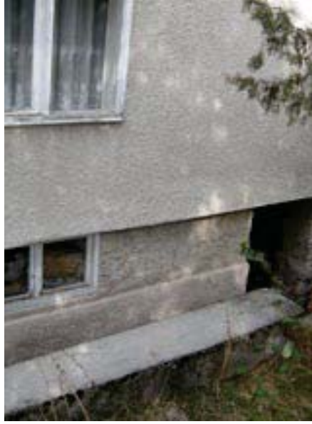
Resim 8: Konutların bodrum katları
