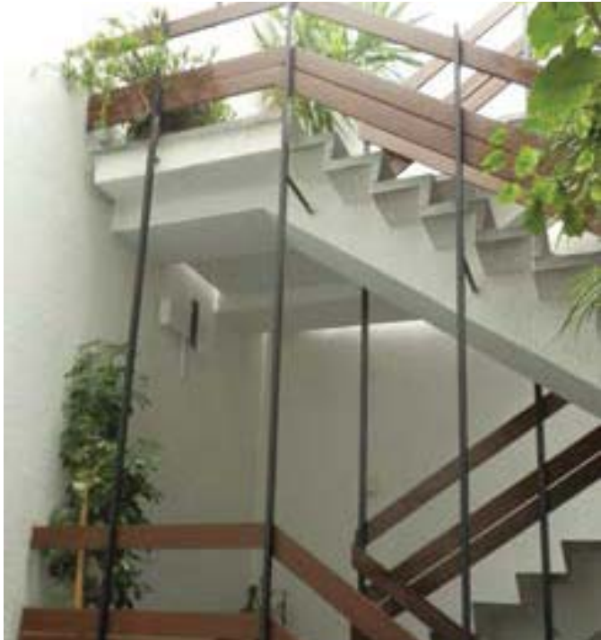
Resim 7 Galeri boşluğundaki metal profiller
